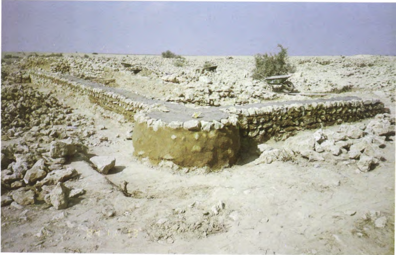
مروب - برج الزاوية الجنوبية الشرقية للقلعة الأولى أثناء عملية الترميم
